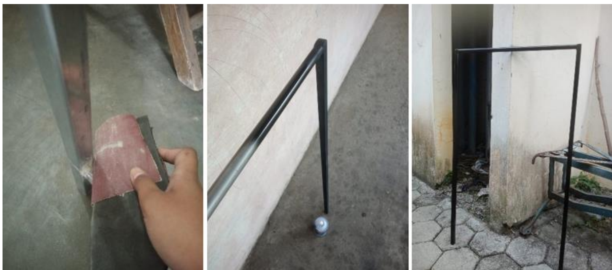
Gambar 8. Pengolahan rangka besi (Sumber : Dokumentasi pribadi)
