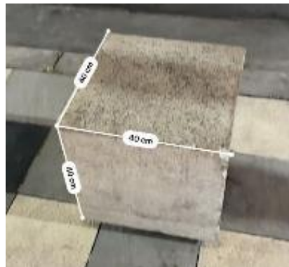
Gambar 3.3. Dokumentasi Pengukuran Bollard/Pembatas Jalan
